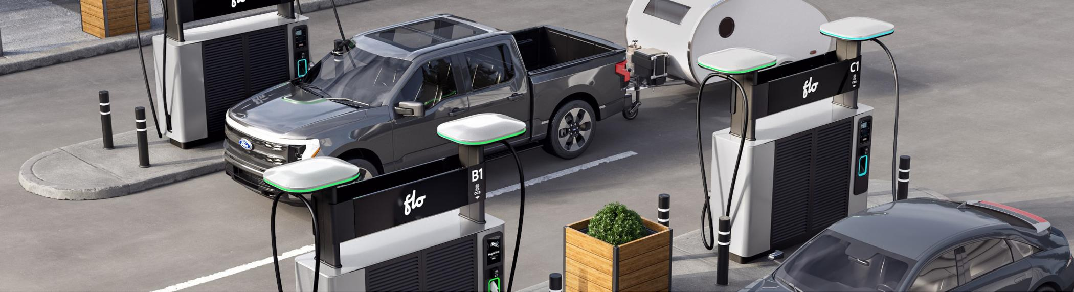
De plus, l'équipement sélectionné influencera l'espace occupé par les bornes de recharge. Par exemple, la conception décentralisée de certaines bornes sépare les modules d'alimentation des connecteurs de recharge. Ces modèles nécessitent toutefois un espace supplémentaire pour les armoires électriques et peuvent entraîner des coûts d'installation plus élevés.
